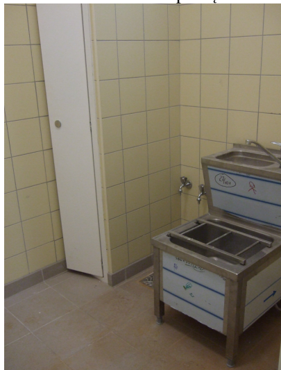
Fot. 9. Pomieszczenie porządkowe
