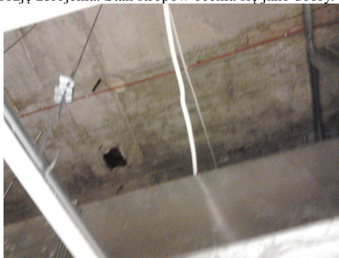
Fot. 2. Strop – widok od dołu
